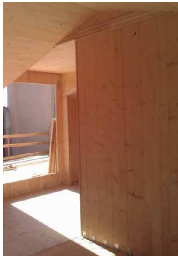
Fotografia 2. Interior amb paret de CLT.
